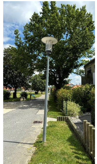
Photo des luminaires existants
