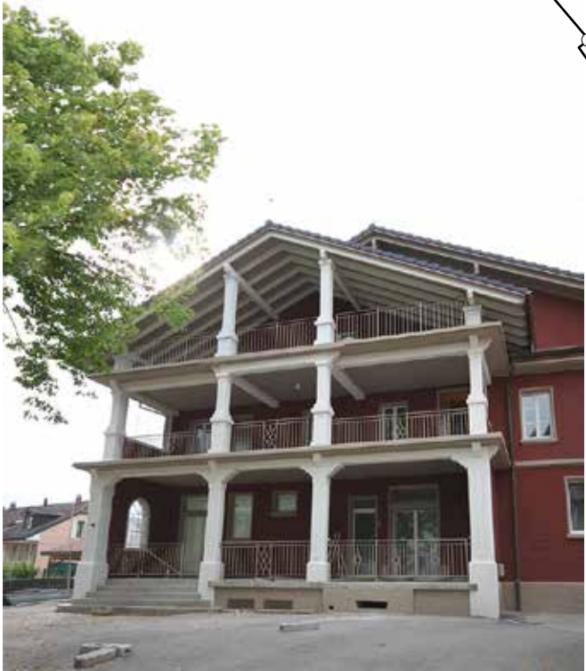
Côté sud-est du bâtiment actuel.
