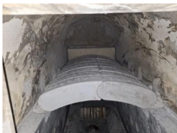
CAD Pampigny – Importants travaux sur le chauffage à distance suite à l'effondrement de la voûte
